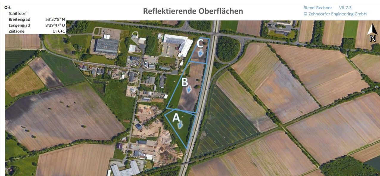
Abbildung 4 Ausrichtung der Anlage
