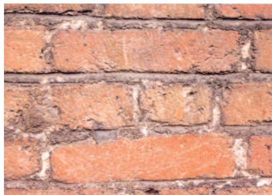
Geriefeltes Backsteinmauerwerk
