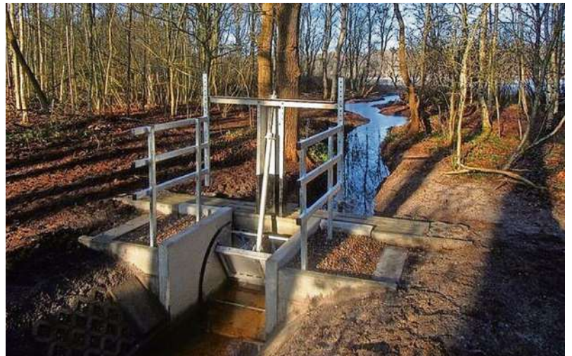
Ein neues Stauwehr reguliert den Pegel des Silbersees im Abflussgraben. Foto: Paul Müller/UNB Landkreis Cuxhaven
