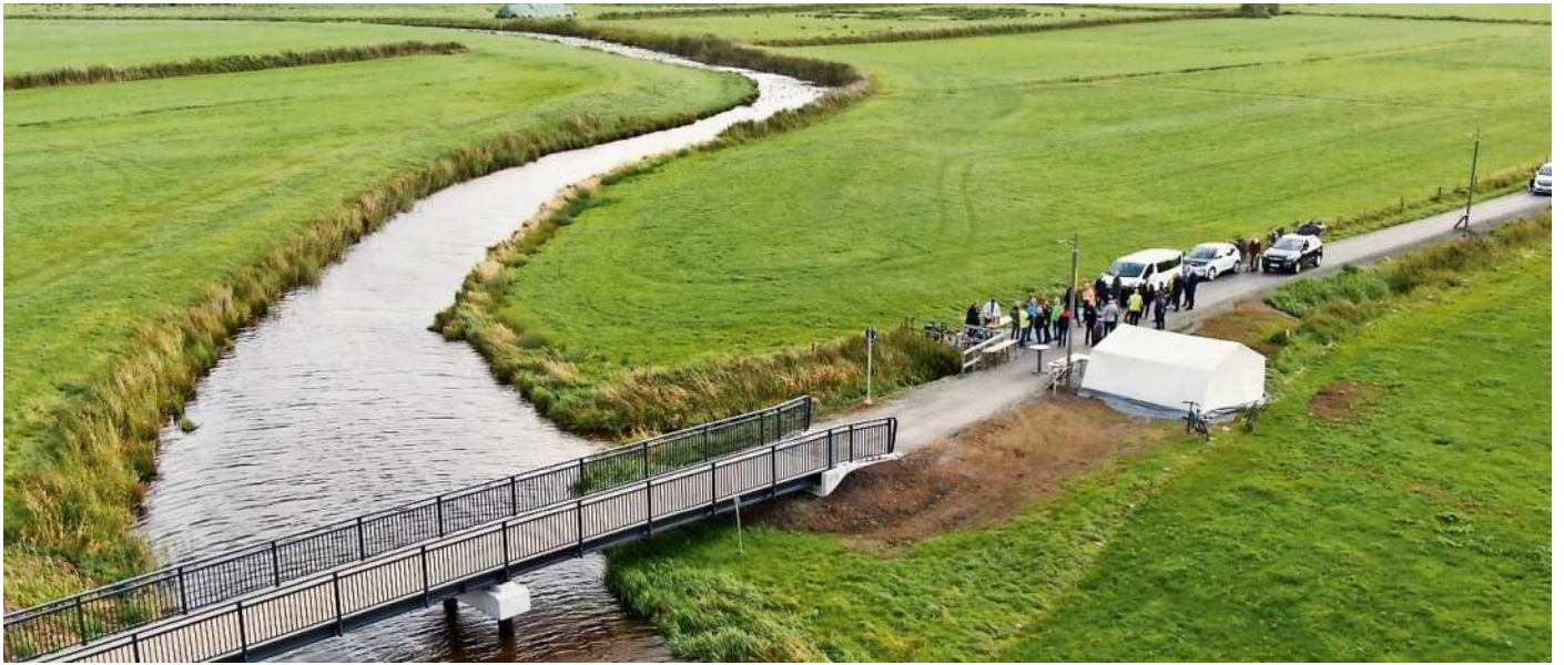
Der neue Radweg „Alte Geestequerung“ reicht von der Schiffdorfer Stauschleuse bis zum Ortsrand von Spaden.
