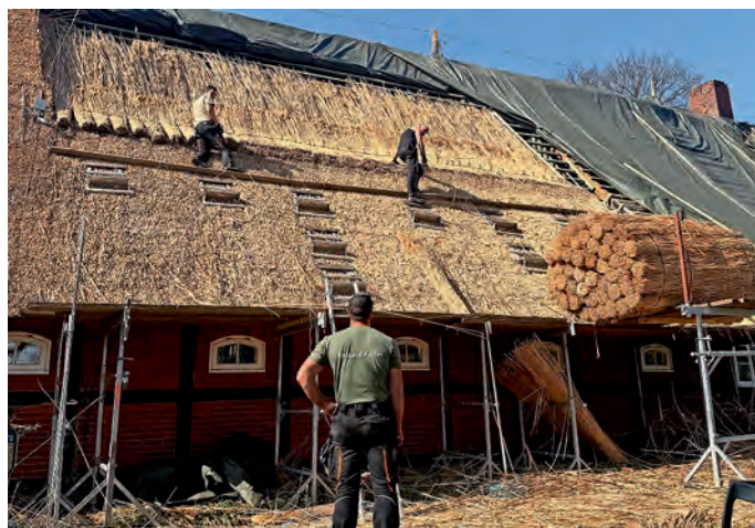
Die Neueindeckung des Reetdaches trägt zum langfristigen Erhalt des Hauses bei.
